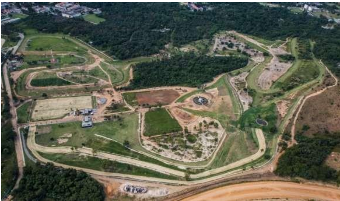
Obras de adequação do Parque Equestre
